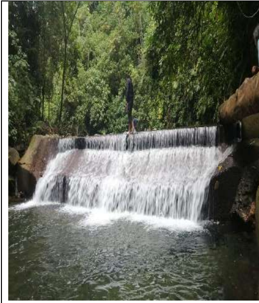
Inspección técnica a villa nueva para nueva galería filtrante
